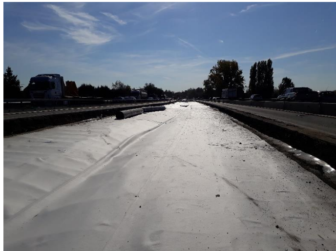
Pose de l'étanchéité sur le géocomposite
