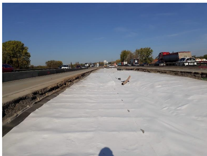
Vue finale après installation du géotextile supérieur
