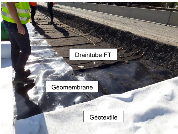
Mise en place du géotextile et succession des couches
