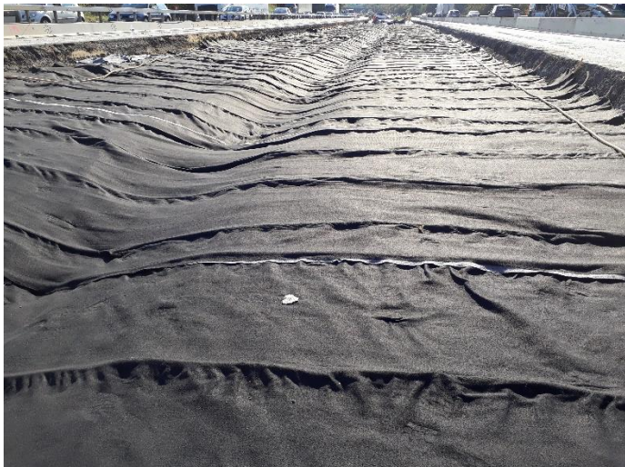
Installation du Draintube sur le sol support
