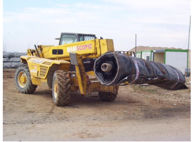
Stockage et transport du produit sur chantier
