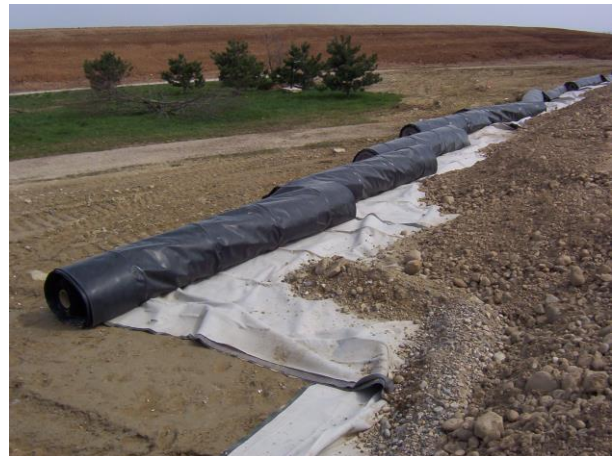
Pose du DRAINTUBE
