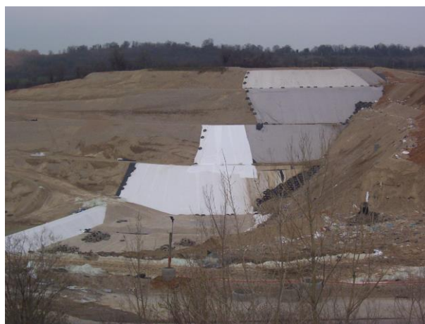
DRAINTUBE FTP® en couverture de casier
