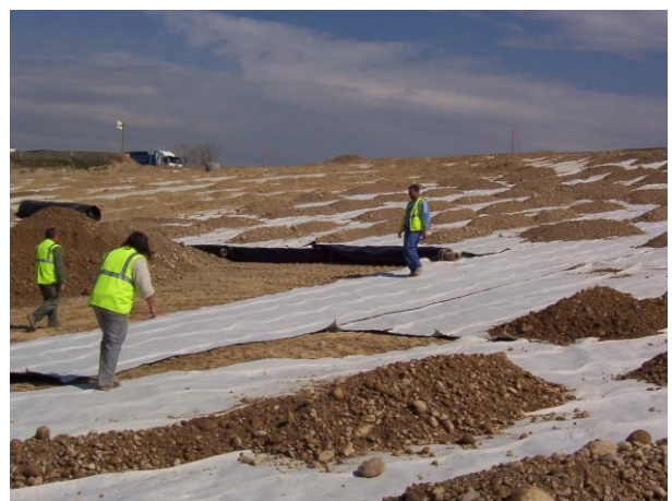
Recouvrement par la terre végétale
