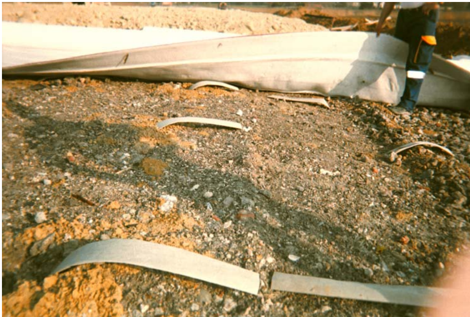
Photo 2 : Drainage horizontal associée aux drains verticaux
