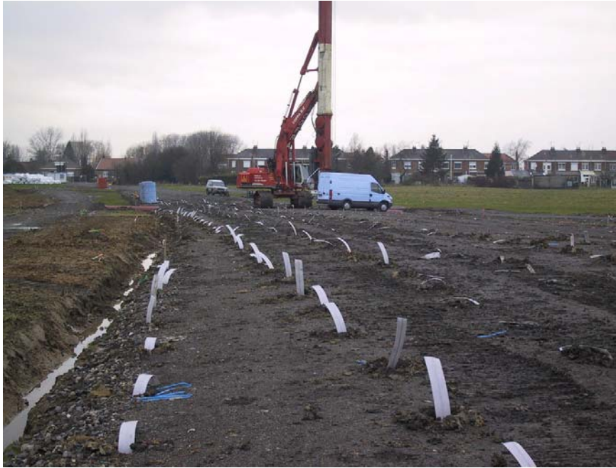
Photo 1 : Mise en place des drains verticaux géosynthétiques
