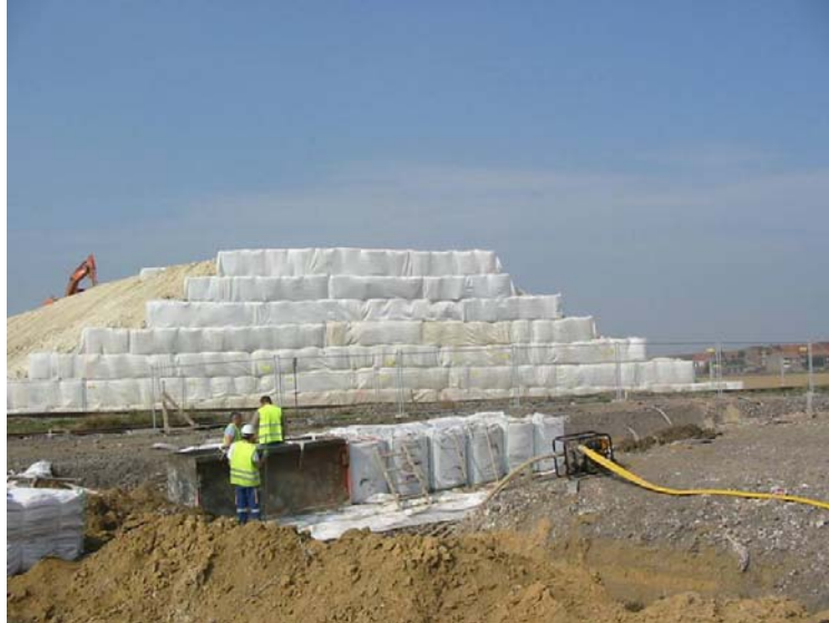
Photo 4 : Aspect final des murs renforcés
