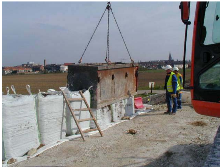
Photo 3 : Vue des big-bag et du coffrage amovible
