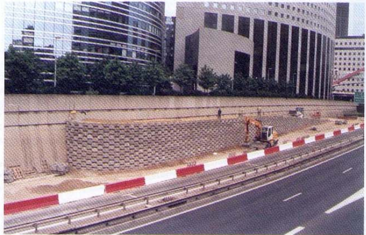
Photo 4 Vue d'ensemble de l'ouvrage en construction Overall view of the structure undergoing construction
