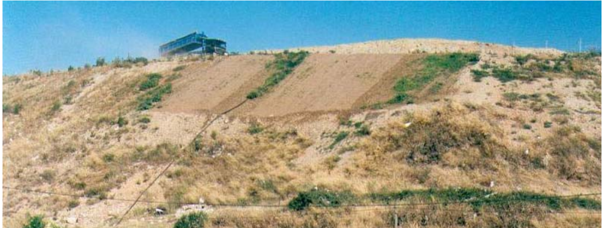
Pose d'une nappe de coco sur l'Alveoter
